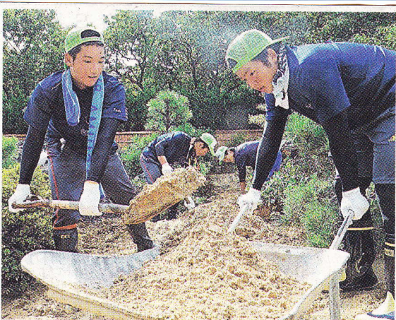
江津市敬川町の住宅の庭に押し寄せた土砂を取り除く石見智翠館高校の生徒たち
